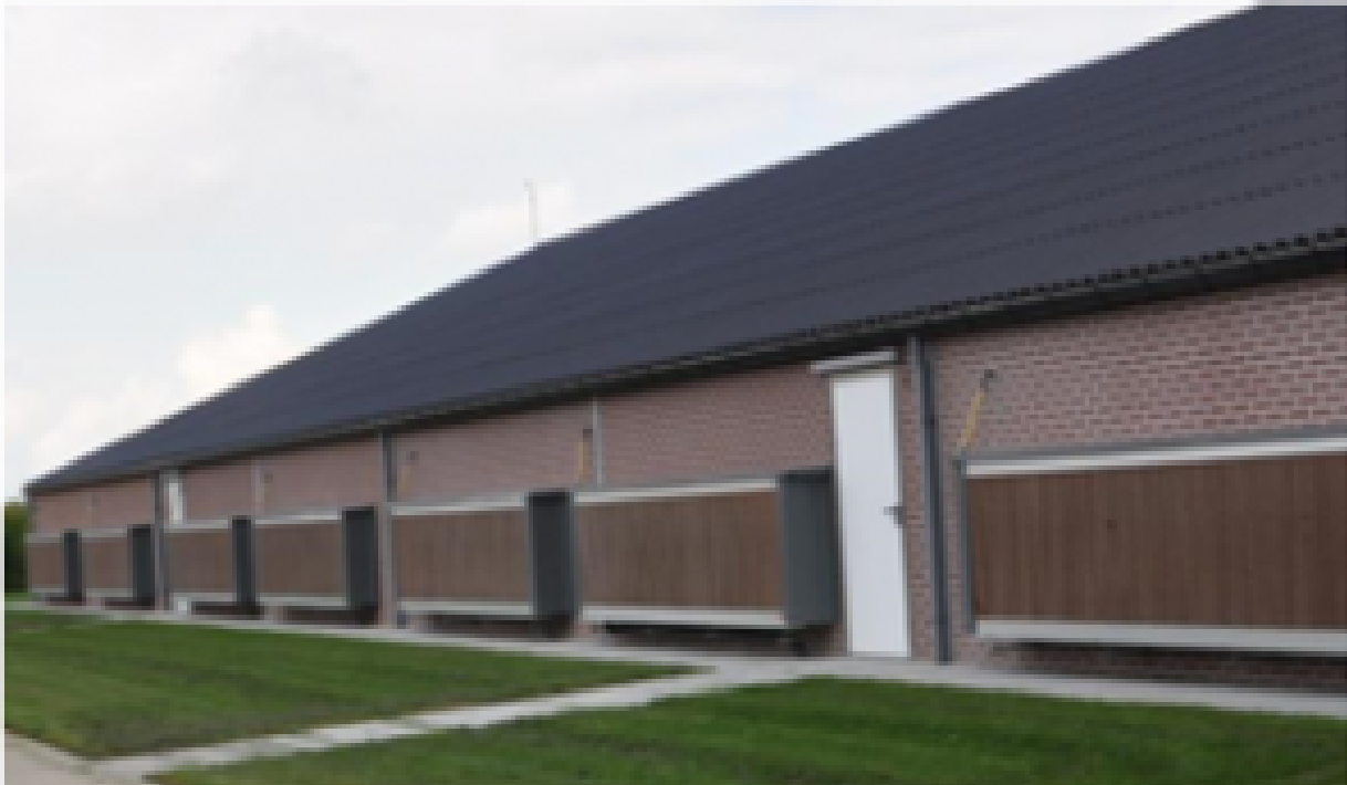
Padkoeling aan de vleeskippenstal (Foto Proefbedrijf Pluimveehouderij)
