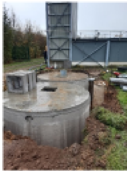
Foto 4: Containeropstelling voor de zuivering van spoelwater met ondergrondse opslag
