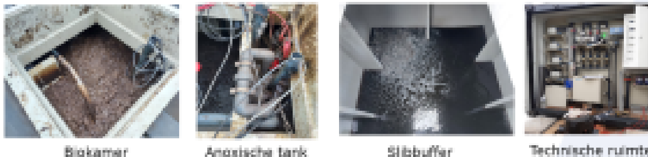
Figuur 2: Overzicht van de verschillende compartimenten in de zuiveringscontainer.
