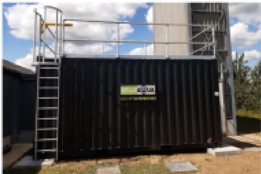
Foto 4: Containeropstelling voor de zuivering van spoelwater met ondergrondse opslag
