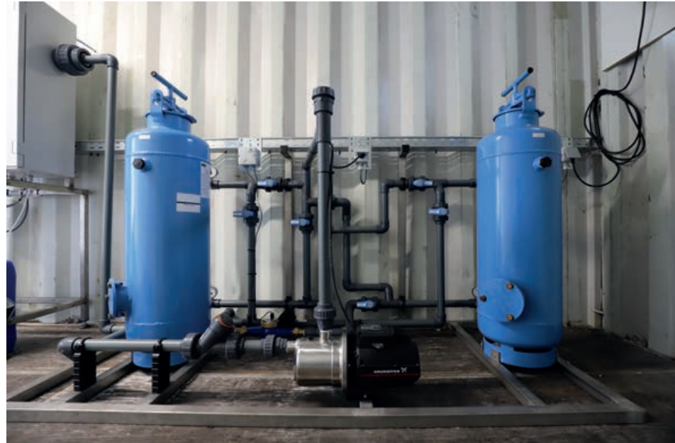
Links het zandfilter gericht op verwijderen van organische belading. Rechts de actieve koolstoffilter gericht op het verwijderen van chemische polluenten. Onderaan bevindt zich de Grundfos-pomp.
