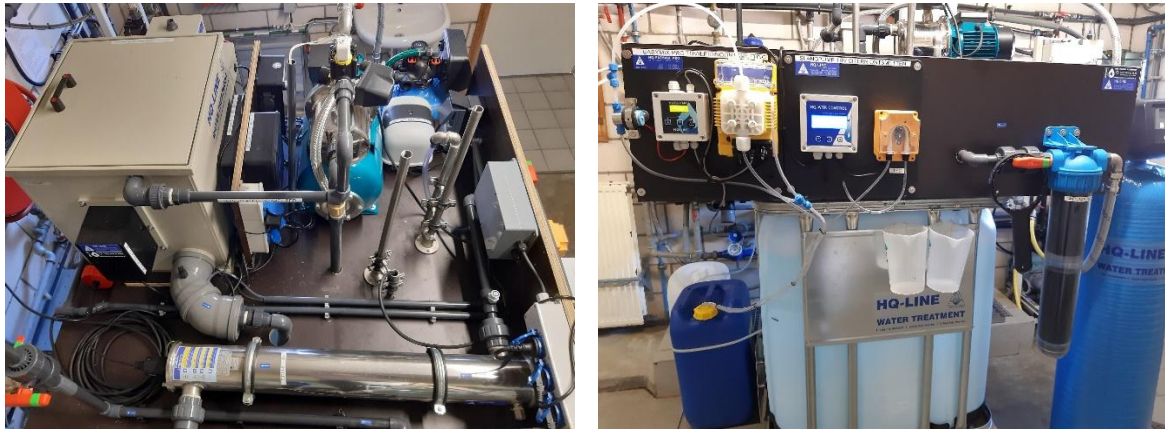
Figuur 3: Boven- en zijaanzicht van de opstelling van de 'zuiveringstrein' op het Proefbedrijf Pluimveehouderij.
